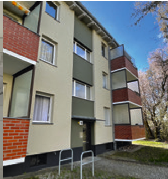
WA 240 - Mariendorf I Erneuerung Fassadenanstrich
