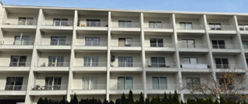
WA 800 Ernst-Reuter Siedlung - Fassadeninstandsetzung
