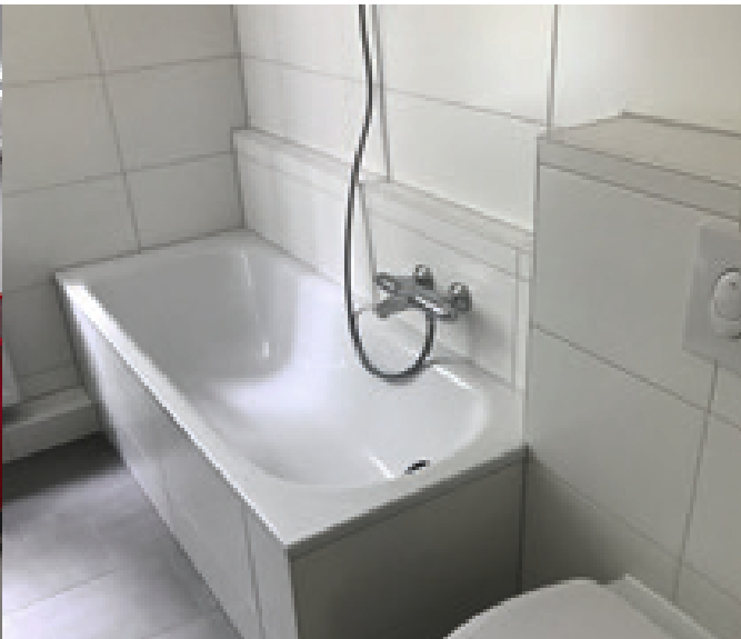
WA 115 Schöneberg II - Bad Modernisierung
